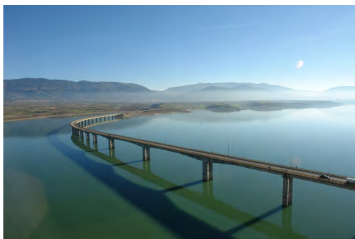
Η σημερινή γέφυρα Πολυφύτου
